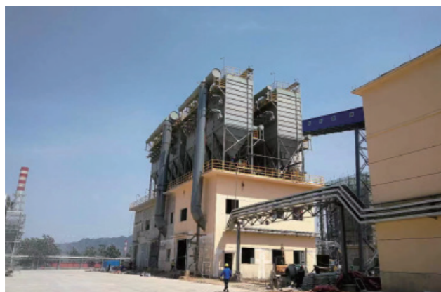
首钢水厂矿业布袋除尘器
